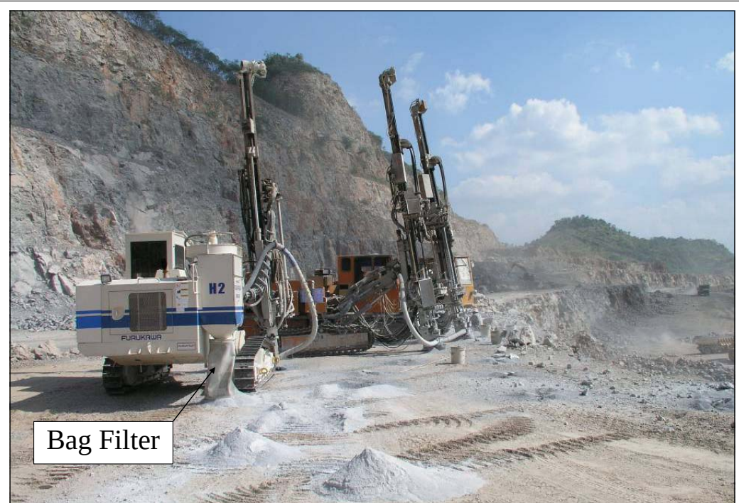
รถเจาะ Hydraulic ติดตั้งระบบถุงกรอง Bag Filter
