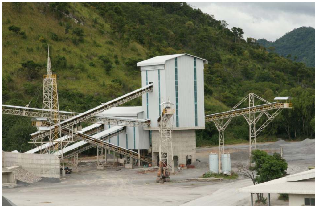
ระบบควบคุมฝุ่นโรงโม่หิน- ปิดคลุมโรงเรือน
